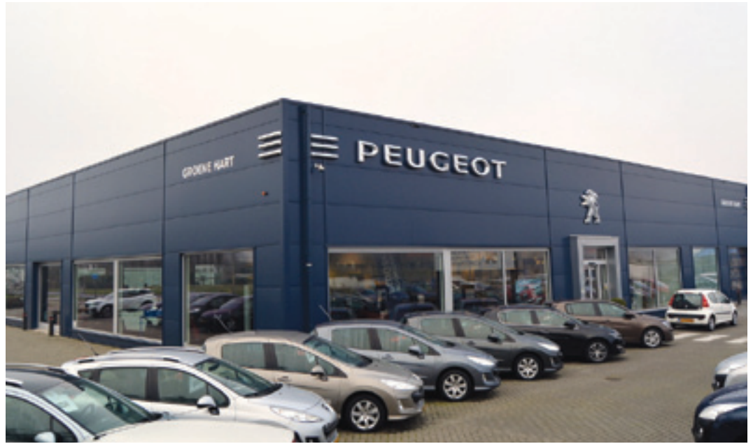
De nieuwe Peugeotgarage aan de Zuidelijke rondweg
